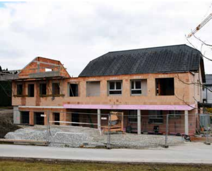
Die Umbauarbeiten sind in vollem Gange.
